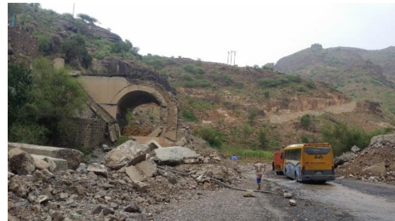
Brücke zwischen Sana'a und Hodeidah zerstört durch Luftangriffe 2017. Juni 2017. © HI
